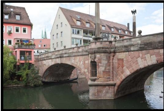
Puente de Carlos
